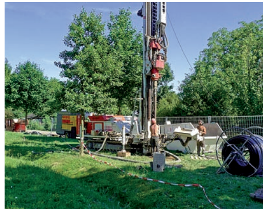
▲ Sonnenberg, Erwärmebohrung Foto: Website Erdwärmeliga
