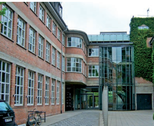
▲ Werkzentrum Weststadt Foto: Schuchert, HFT
