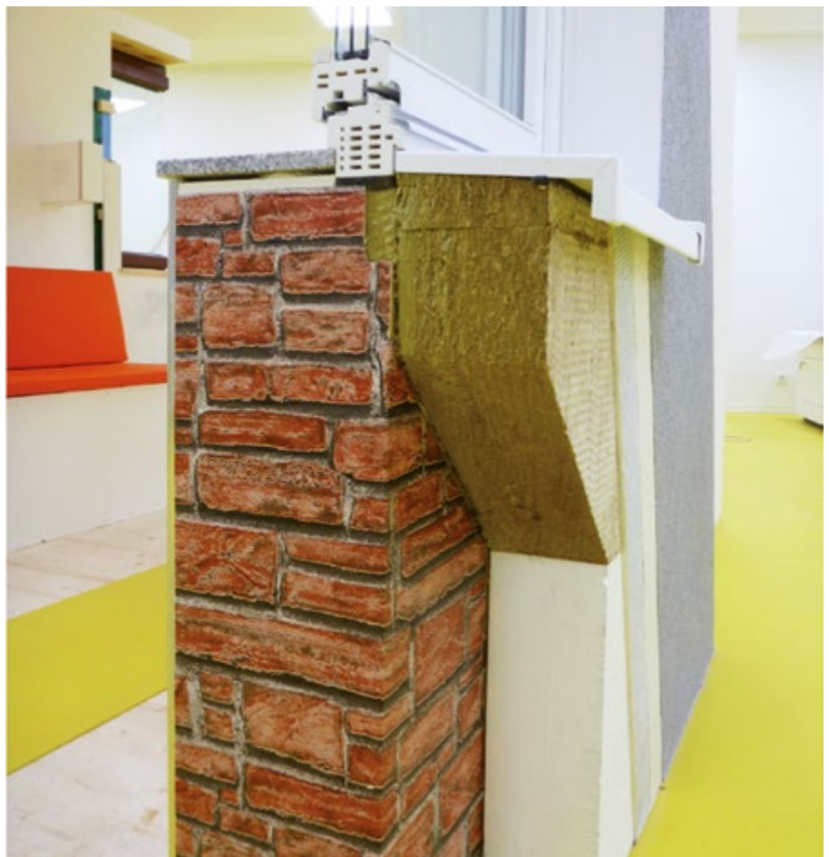
Energiemusterhaus: Sockeldämmung mit feuchteunempfindlichen Dämmmaterialien
