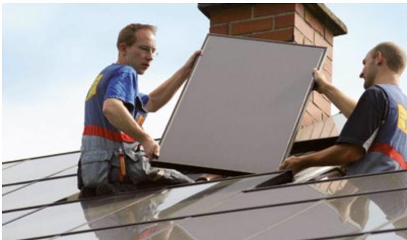
Installation Photovoltaikanlage © Ludwigsburger Energieagentur LEA e.V.
