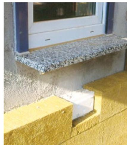
Dämmung der Außenwände und Einbau einer Lüftungsanlage.
