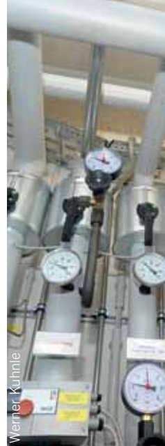
Die Wärmerückgewinnungsanlage entzieht der Abluft Wärmeenergie und heizt damit einströmende Frischluft wieder auf.
